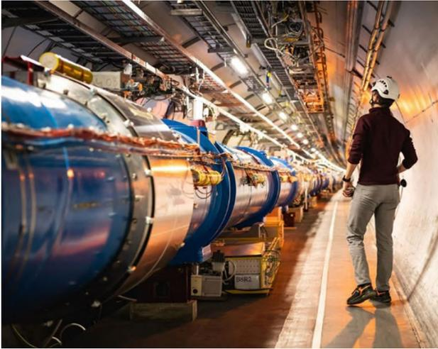
**Figura 2.** En este tramo del anillo subterráneo de 27 kilómetros del LHC, se pueden observar los tubos por donde circulan los haces de partículas subatómicas a velocidades cercanas a la luz (LHC Deutschland, s. f.).
